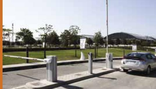
Une lisse et une structure renfermant tant l'automatisme que l'électronique de commande suffisent pour limiter la circulation dans une zone définie.
